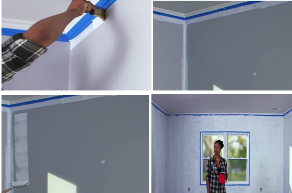
Figure 0-9 Apply the Primer
